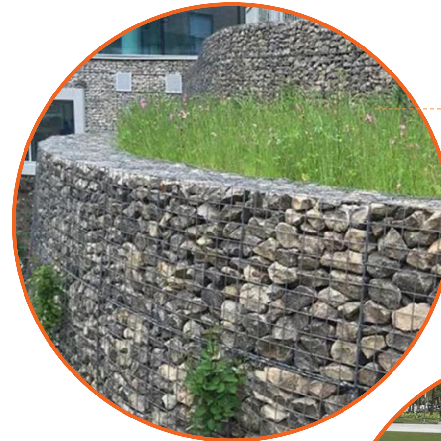
Gabion walls Paredes de gaviones
